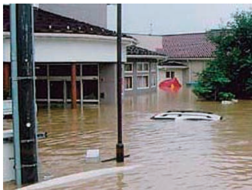
新潟豪雨時の被災状況（きらきら保育園：三条市）
