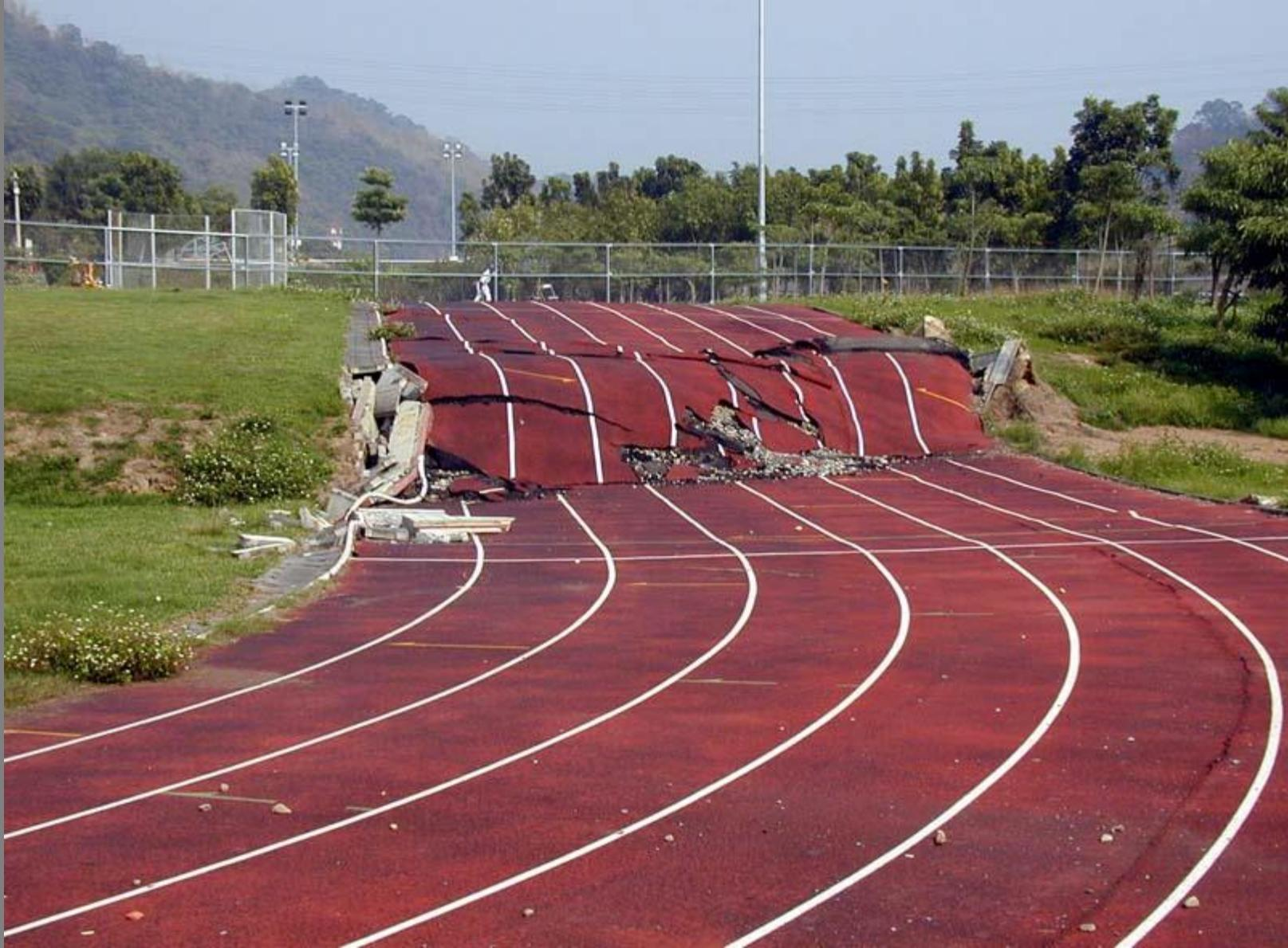
霧峰の光復中学校の運動場を横切った地震断層。トラック舗装面が重なってしまっていることから、東西から押しつけられた逆断層であることがわかる。
