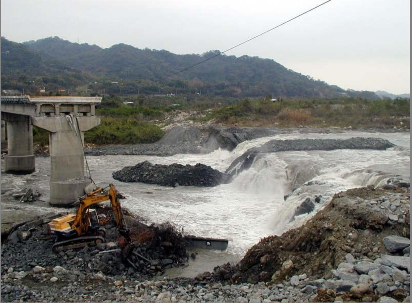
断層変位によって大甲溪に生じた滝と、落下した橋。ふだんは清水が流れているが、一週間前の大雨のため濁流となっている。
