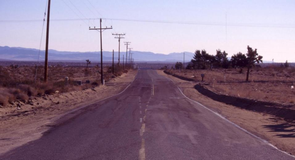
1992年6月28日のランダース地震(M7.3)によって食い違いが生じた舗装道路. 断層を挟んで向こう側の地塊が右へ約2mずれたことが,センターラインが平行移動していることからわかる. 斜めのラインは地震後に書き加えられたもの. ランダース地震のときには複数の断層が地表に変位を形成した. これはジョンソンバレー断層.
